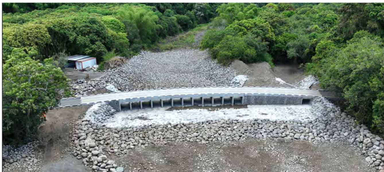
Figure 4 : Réhabilitation du radier d'accès à l'ilet Danclas
